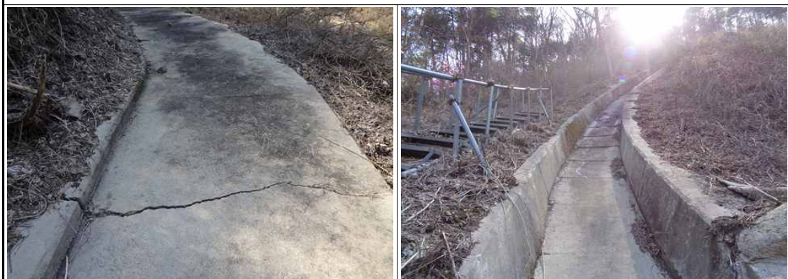
② 정면 STA.-18 1소단배수로 균열 ⇨ 균열보수
